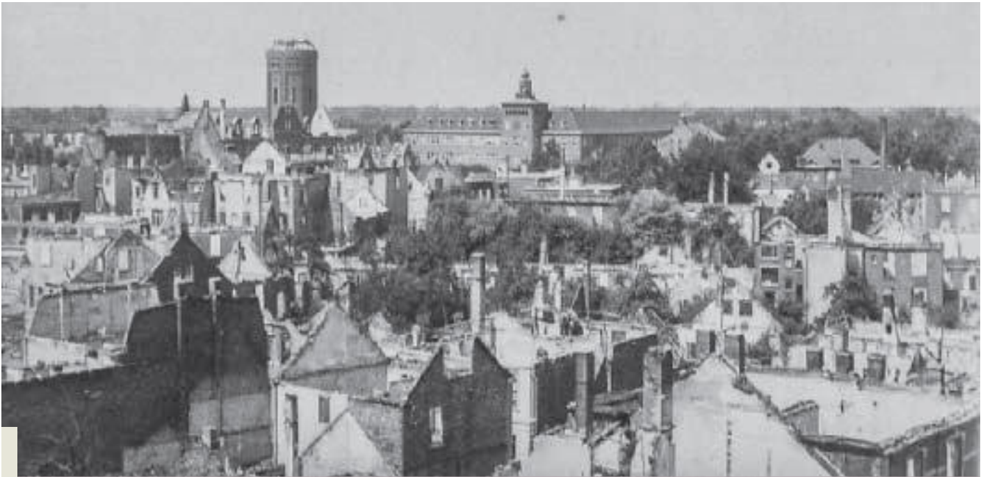
Foto mit Blick auf das weitgehend unzerstörte St.-Georg-Gymnasium und den Wasserturm
